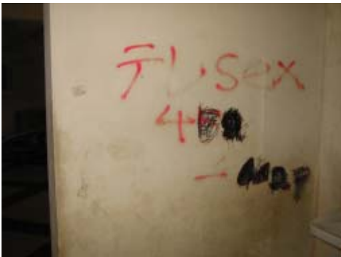
写真5 . トレーニングルームの建物1階の壁
