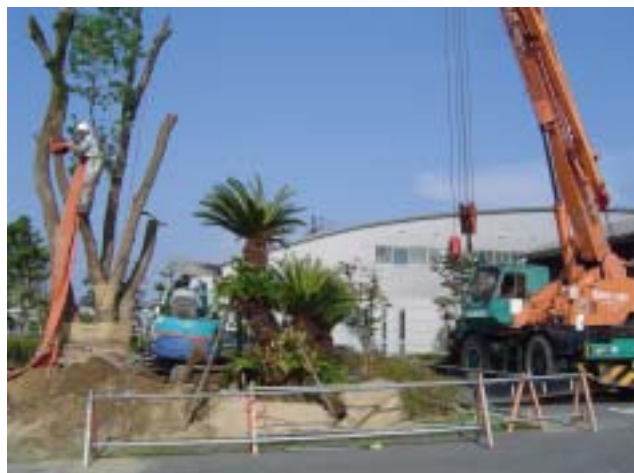
使用機械 25 トン ラフタークレーン 11 トン トラック バックホー 0.1 m 3
