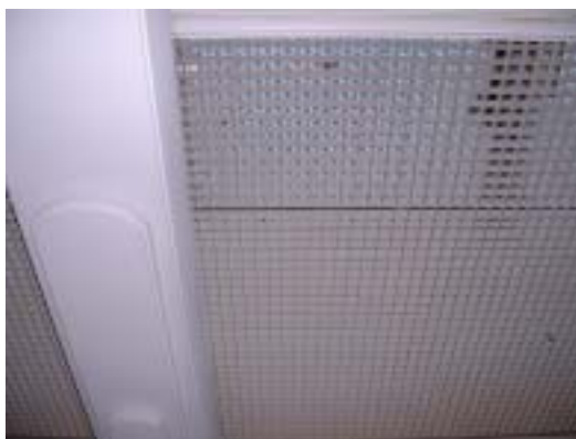
10号館1階の天井
