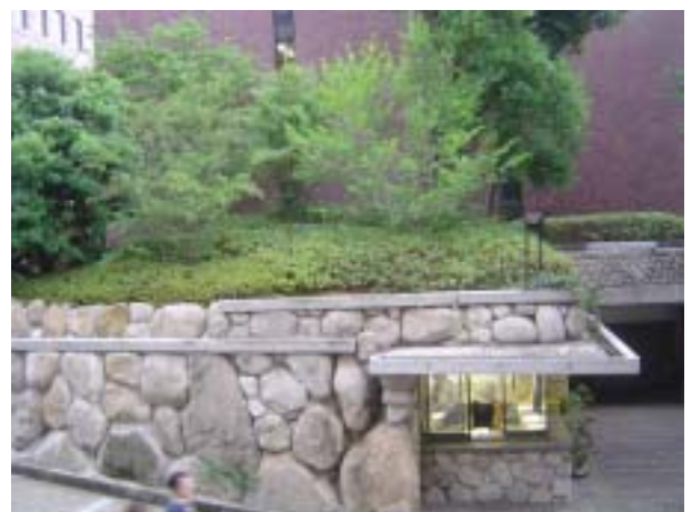
10号館守衛室上部 刈込み 作業後
