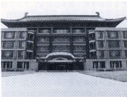
写真① 北京大学図書館
