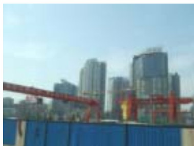
建設ラッシュの北京市内
